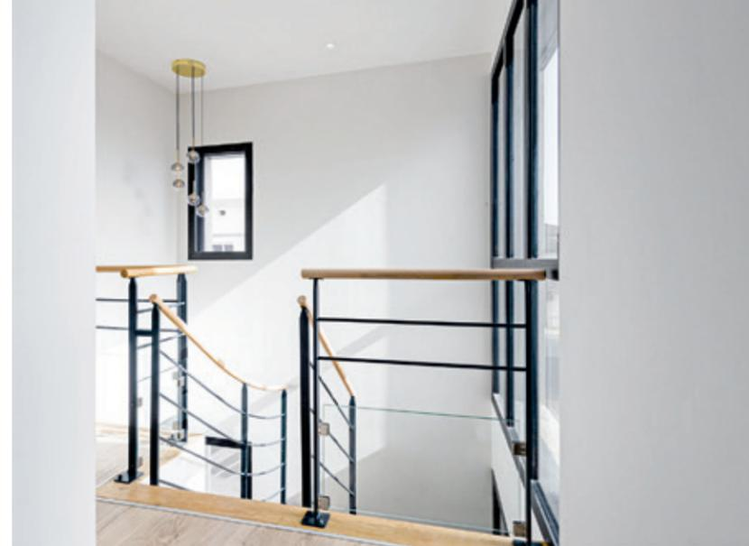
**Assorti à l'escalier,** le garde-corps est constitué d'un assemblage de métal. Il se prolonge à l'étage pour sécuriser la mezzanine, et il est complété d'une plaque de verre en partie basse.
